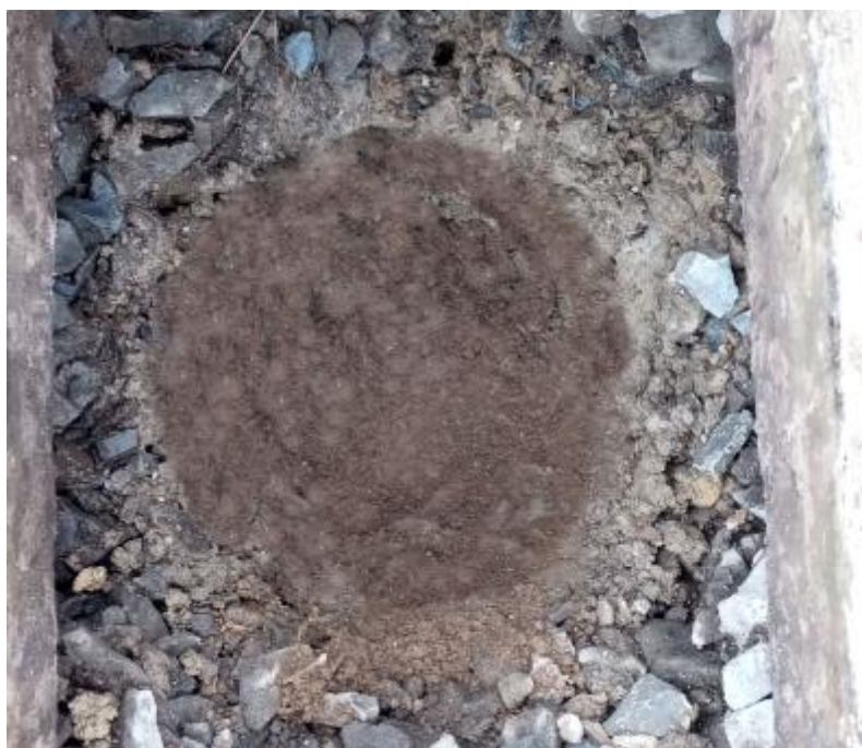
Pohled na dno kopané sondy K1 před realizací SZZ_1 v úrovni po kamenném štětu (přezd P2236 v km 20,712)
