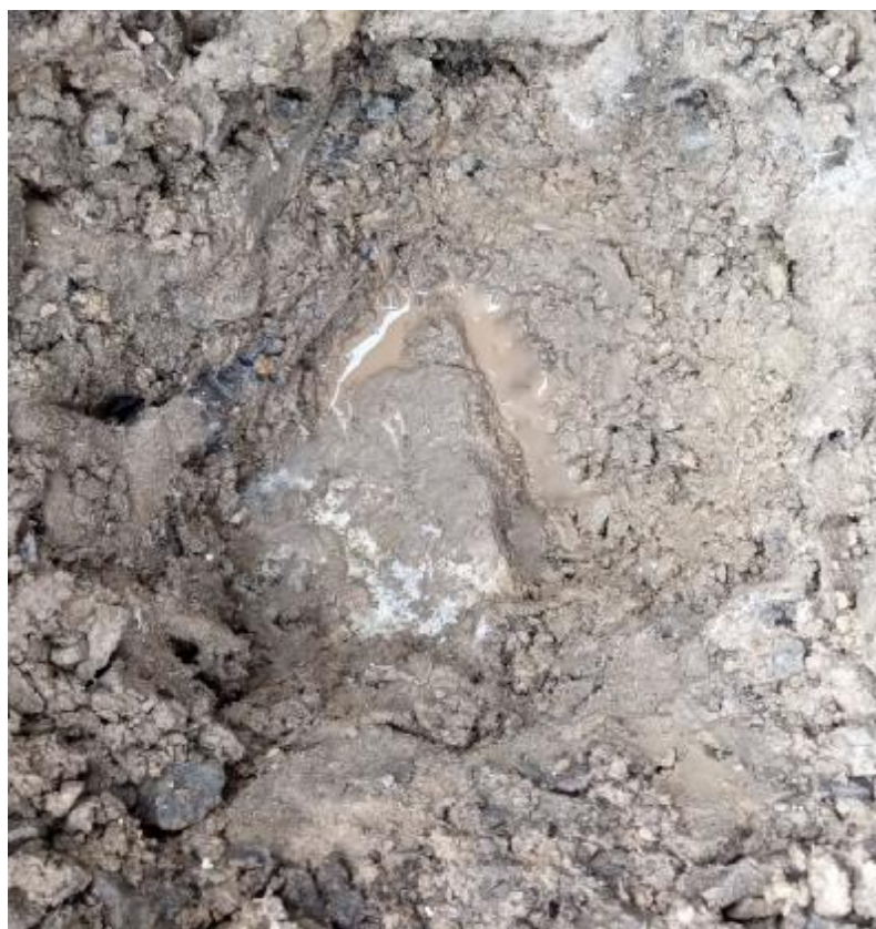
Kamenný štět zastížený v průběhu realizace kopané sondy K1
